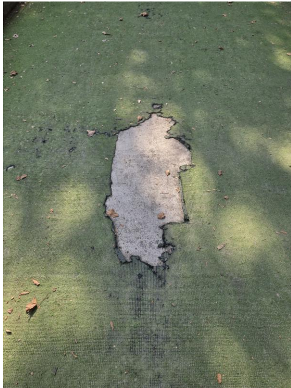
Foto 2 - Dettaglio del panno deteriorato, con il fondo sottostante esposto del campo di sinistra.
