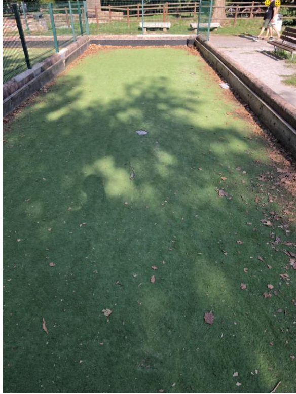
Foto 1 - Vista d'insieme del campo di destra e del lato esterno privo di recinzione laterale.
